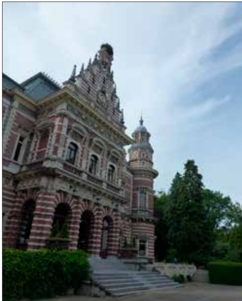
Kasteel Oud-Wassenaar met het nest bovenop de sierlijke gevel
