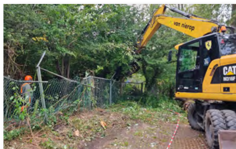
Verwijderen van het beschadigde hek
